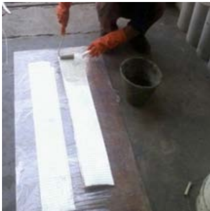
(a) Penerapan resin epoxy pada E-GFRP
