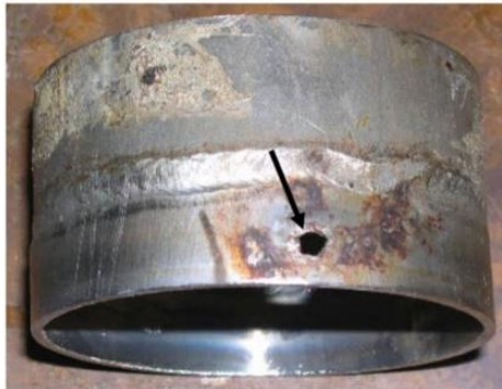
Gambar 2.14 Korosi sumuran pada saluran perpipaan (Tait, 2018)
