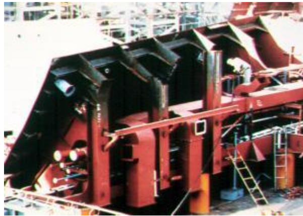
Gambar 2. 4 On-block outfitting pada side shell di ruang mesin (Sumber: Storch et al., 1988)
