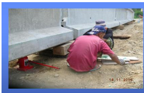
Gambar 4. 11Siapkan Multiplek Untuk Alas Girder
