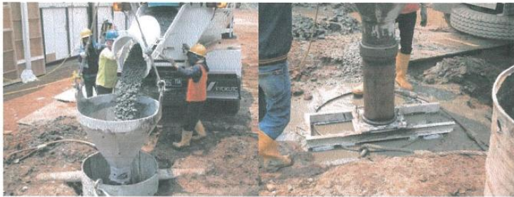
Gambar 4. 4Pengecoran Beton
