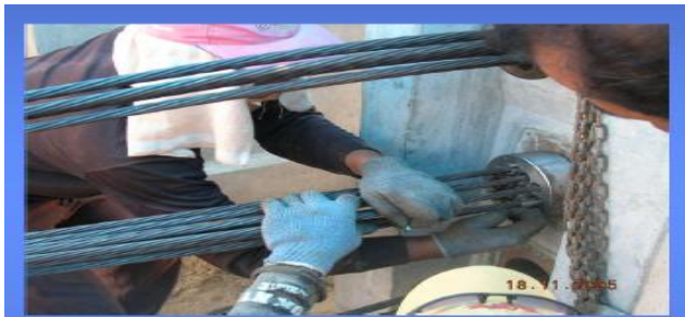
Gambar 4. 13 Pemasangan Wedges Kedalam Anchor Block
