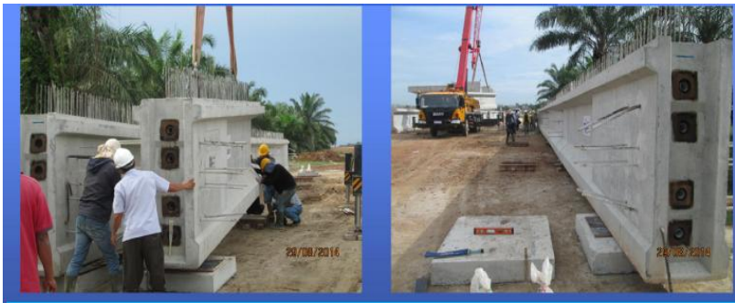
Gambar 4. 9Memposisikan Stressing Bed
