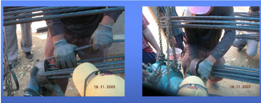
Gambar 4. 12 Pemasangan Anchor Block
