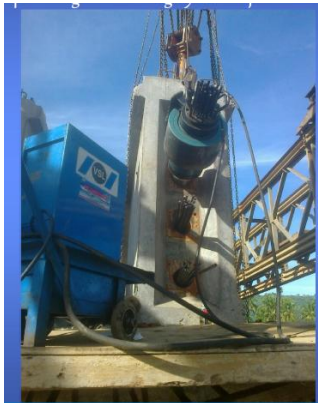
Gambar 4. 15Pemasangan Gripper Plate Pada Bagian Hydraulic Jack
