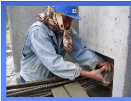
Gambar 4. 35 Tekuk PE-grout Pada Lubang Inlet dan Ikat Dengan Kawat Benfrat
