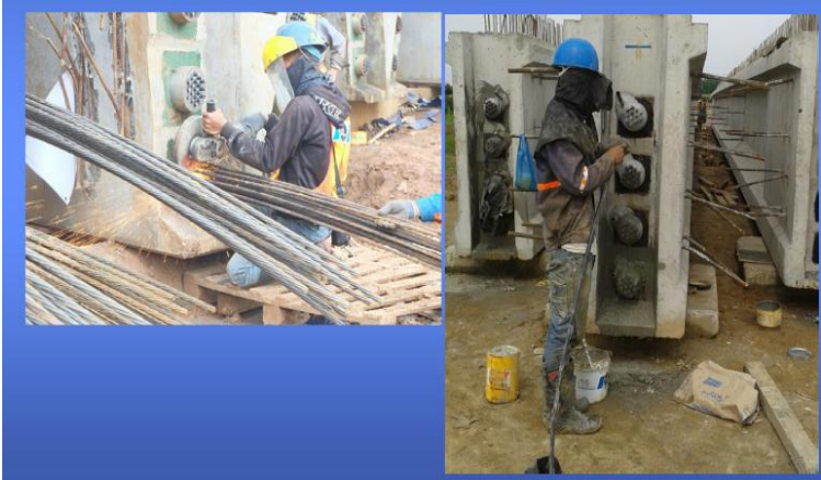
Gambar 4. 33 Grout Pump Dihubungkan dengan Lubang Inlet
