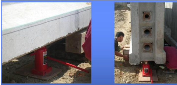
Gambar 4. 10Cek Kelurusan Segment Girder Dengan Hydraulic Jack
