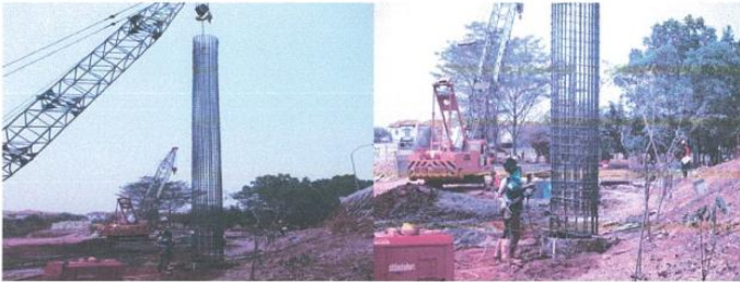
Gambar 4. 3Pemasangan Besi Tulangan
