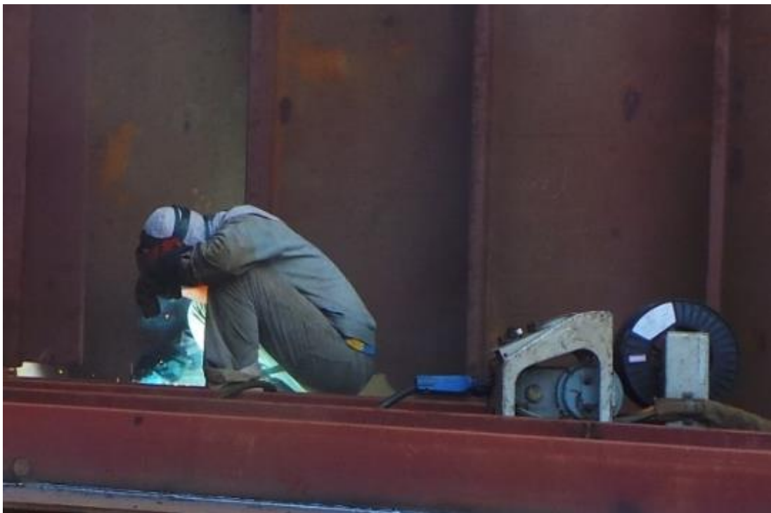
Gambar 4.10. Pengelasan FCAW di Building Berth pada Proses Assembly
