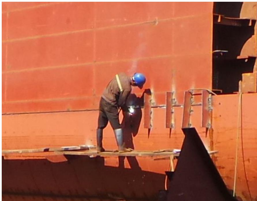
Gambar 4.3. Mengelas Posisi 2G
