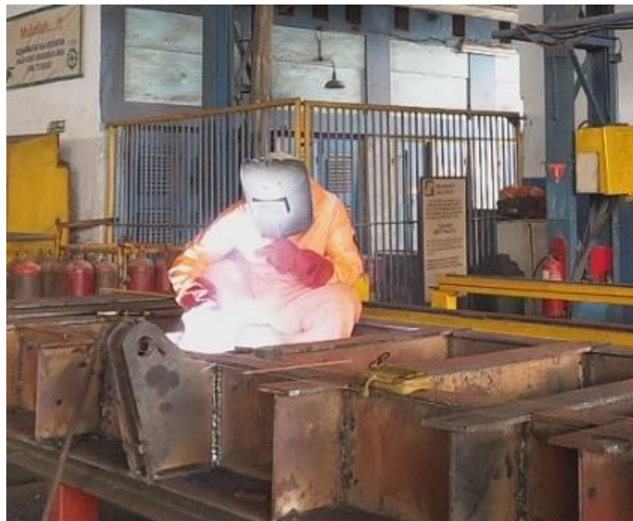
Gambar 4.8. Pengelasan SMAW di Bengkel Lambung pada Proses Sub-assembly
