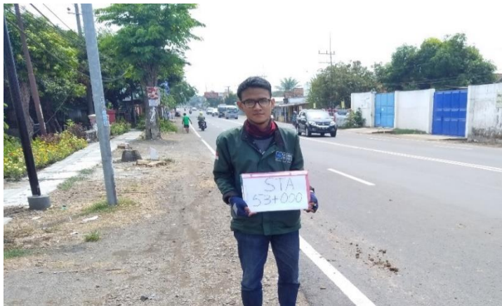
Gambar 1.7 Kondisi Jalan STA 53+000
