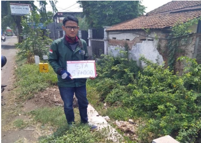
Gambar 1.12 Kondisi Drainase STA 57+000
