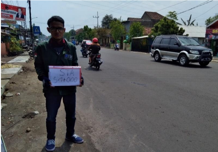
Gambar 1.8 Kondisi Jalan STA 54+000
