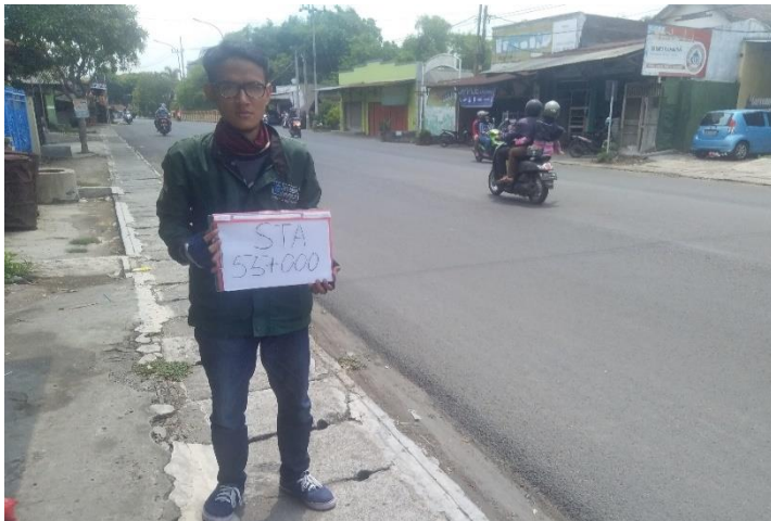
Gambar 1.9 Kondisi Jalan STA 55+000
