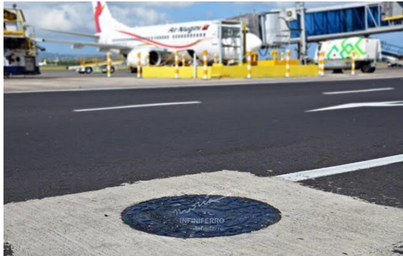
Gambar 3. 1 Manhole Bandar Udara
