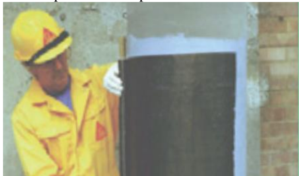
Gambar 2.26. Pemasangan Sika Wrap
