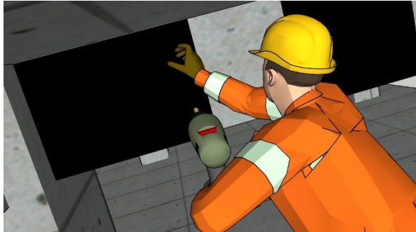
Gambar 9.10. Pasang Baut pada Sika Wrap
