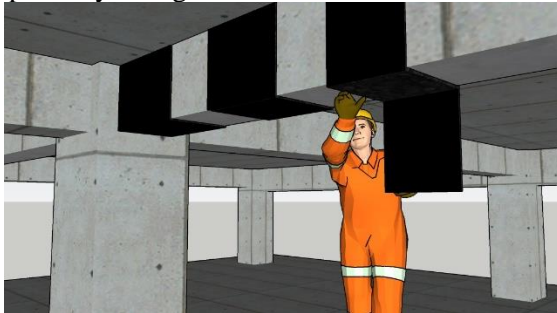
Gambar 9.9. Pasang Sika Wrap pada Beton
