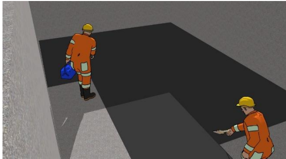
Gambar 9.22. Pelaburan primer coating
