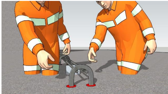
Gambar 9.18. Masukkan tulangan U untuk chemical anchor
