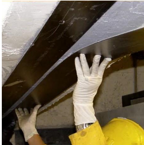
Gambar 2.20. Contoh Pemasangan CFRP
