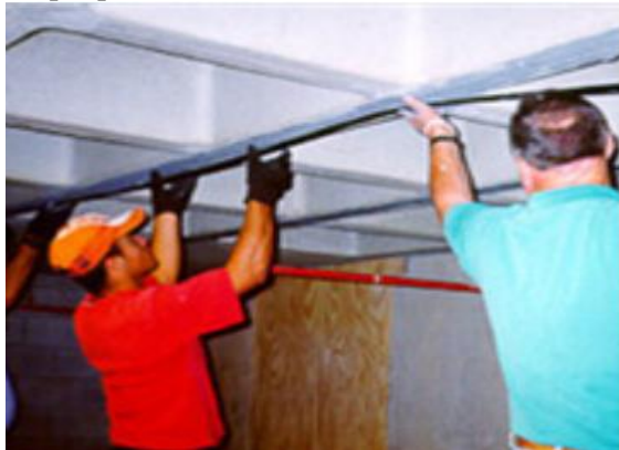
Gambar 2.21. Pemasangan Pelat Sika Carbodur
