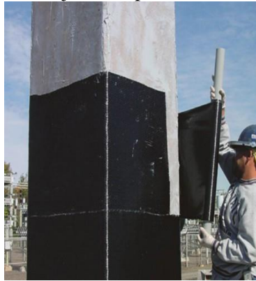
Gambar 2.24. Contoh Pemasangan SikaWrap (Sumber : www.structurmag.org )
