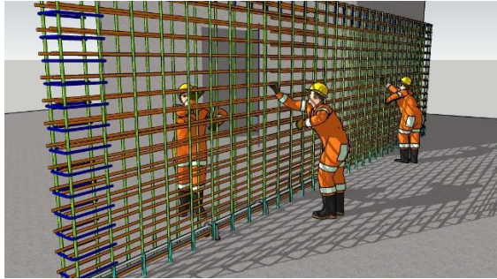
Gambar 9.19. Pemasangan tulangan vertikal dan tulangan horizontal
