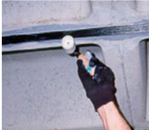
Gambar 2.22. Roller untuk perataan Sika Carbodur
