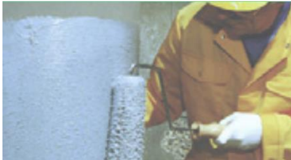
Gambar 2.25. Pemasangan resin Sikadur -330
