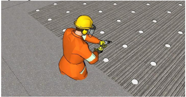
Gambar 9.13. Membuat lubang untuk perletakan chemical anchor
