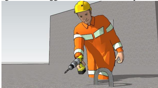
Gambar 9.17. Masukkan tulangan U untuk chemical anchor
