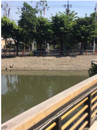
Gambar A.4 Kondisi Air Sungai di Jembatan Yos Sudarso (Titik 4)
