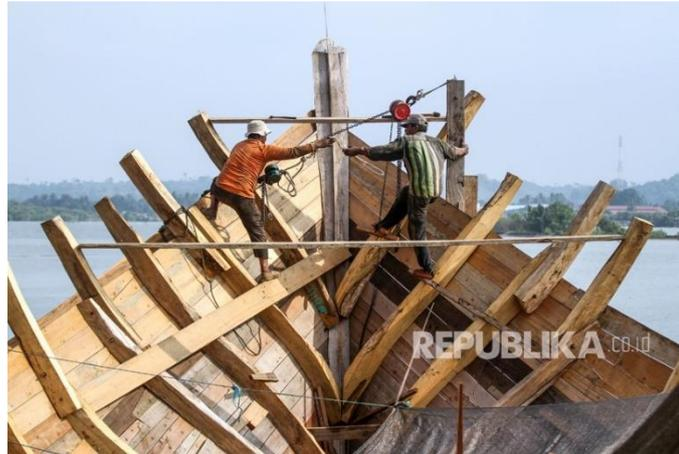
Gambar 2.16 Proses pemasangan gading
