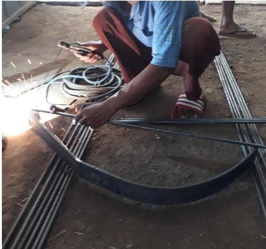
**Gambar. Proses pengelasan dengan betoneser**
