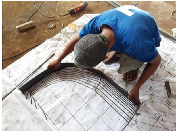
**Gambar. Proses Pencocokan Pada Gambar**
