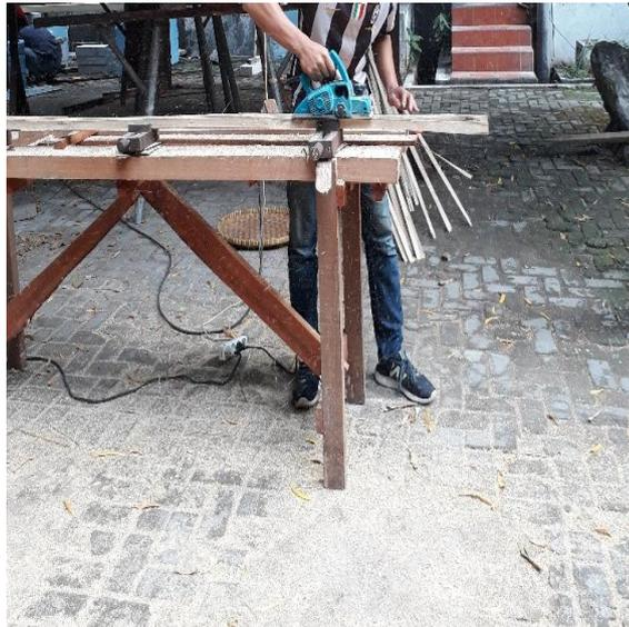
Gambar 4. 10 Proses Perataan Bagian Kanan dan Kiri Bilah Bambu
