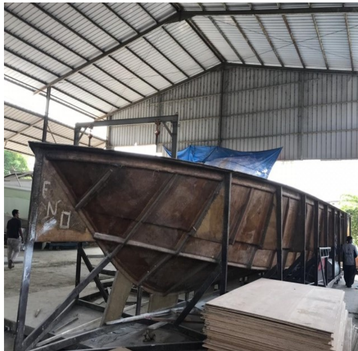
Gambar 4.10 Area pengerjaan tertutup galangan PT. Royal Advance Fiber
