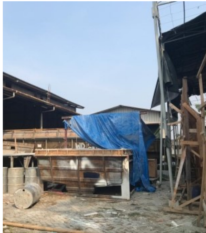
Gambar 4.9 Area pengerjaan terbuka galangan PT. Royal Advance Fiber
