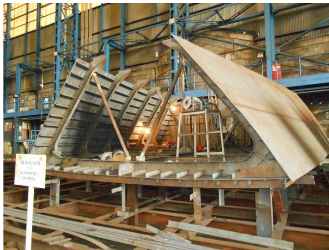
Gambar 4.1 Salah satu proses pengelasan pada tahanan sub assembly
