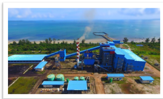
Gambar 2.7 Pembangkit Listrik PLTU XYZ Tipe Boiler CFB dengan Kapasitas 2x16,5 MW
