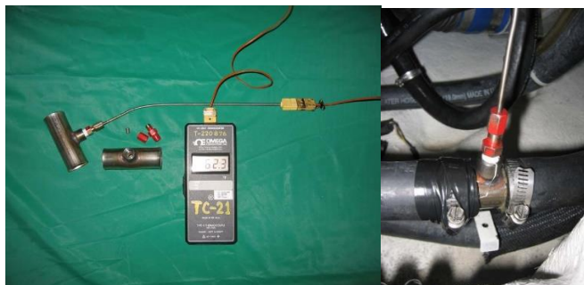
Gambar 0.4 Pemasangan Probe pada jalur pendingin
