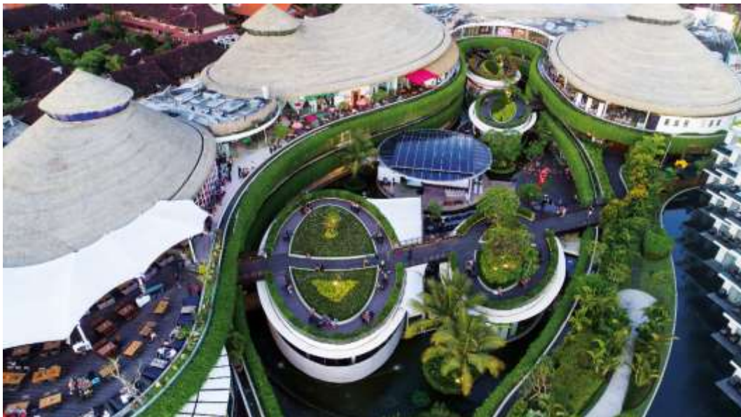
Gambar 2 23 Bangunan Pusat Perbelanjaan Kuta Beachwalk (Nowbali.co.id, 2017)
