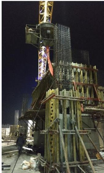
Gambar 4. 6 Pengecoran Kolom
