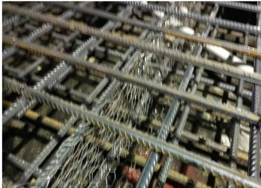
Gambar 4. 9 Pemasangan *Stop Cor*
