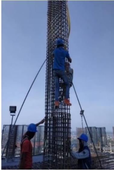
Gambar 4. 4 Penyambungan Tulangan Kolom
