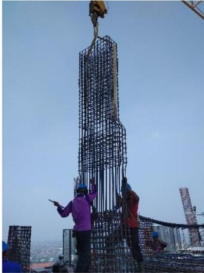
Gambar 4. 3 Pemasangan Tulangan Kolom
