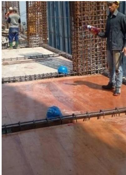
Gambar 4. 8 Pelapisan Bekisting Dengan Minyak Tanah
