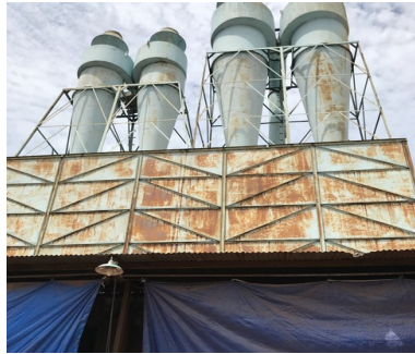
Gambar 4.6 tempat pengumpulan serbuk kayu (kiri), pipa diatap penyedot serbuk kayu (kanan)
