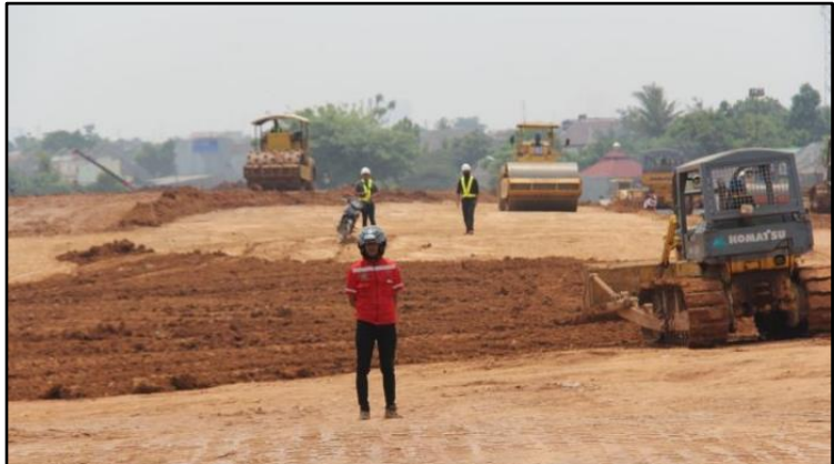
Gambar 5.3 Ilustrasi Pengurugan dan Pemadatan Tanah (Sumber: google.com)
