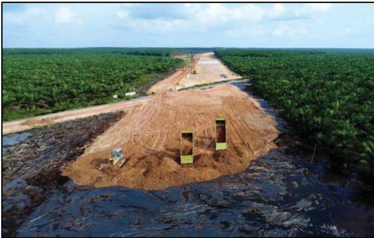
Gambar 5.4 Proses Pembuatan Plate Form (Sumber: dokumen pelaksana)
