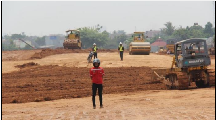
Gambar 5.3 Ilustrasi Pengurugan dan Pemadatan Tanah (Sumber: google.com)
