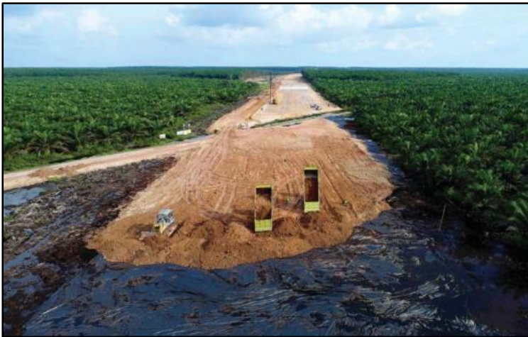
Gambar 5.4 Proses Pembuatan Plate Form (Sumber: dokumen pelaksana)
