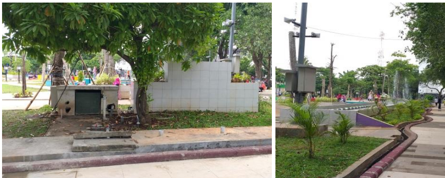
Gambar 4.42 Sistem Pemompa Air dan Selokan pada Alun-Alun Lamongan (Observasi Lapangan, 2019)
