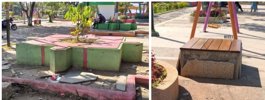
Gambar 4.26 Kerusakan Fisik pada Bangku Taman Alun-Alun Lamongan (Observasi Lapangan, 2019)
