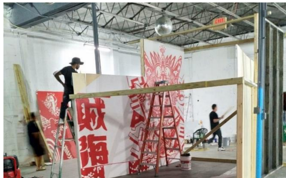
Gambar 2. 26 Sekat yang dibangun dengan plywood (Sumber: Behance YOK and SHERYO)
