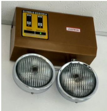
Alarm peringatan di setiap laboratorium komputer
