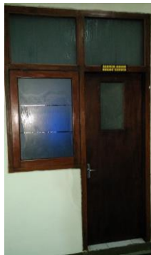
Foto pengamanan ruang server
