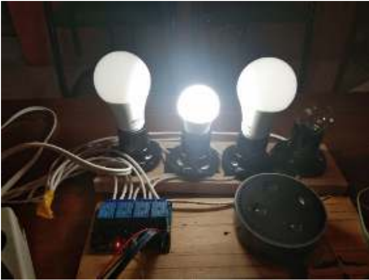
Gambar 4. 4 Kondisi “ Bedroom Light ” menyala
