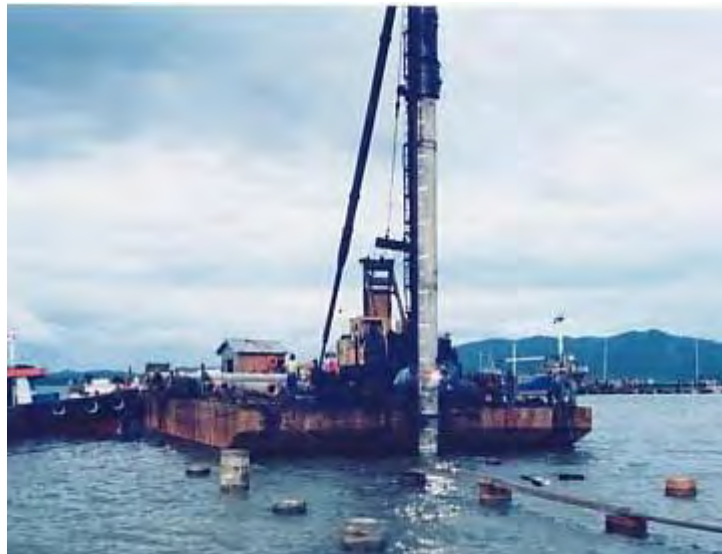
Gambar 7.15. Pemancangan Tiang Pancang
