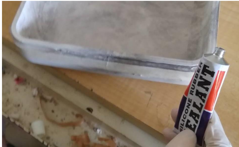
Gambar 5.30 Pemasangan menggunakan perekat kaca Sumber: Penulis, 2020
