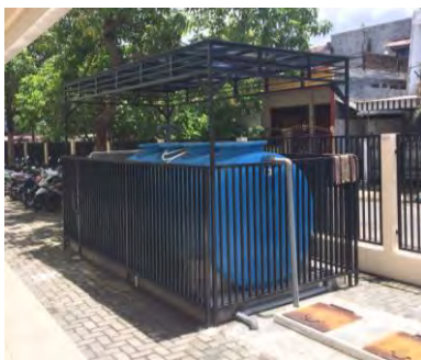
Gambar 5.5 Pengolahan Air Limbah Puskesmas Ngagel Rejo Sumber: Hasil Observasi 2016
