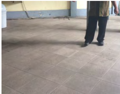
Gambar 5.4 Letak Septik tank Puskesmas Krembangan Selatan
