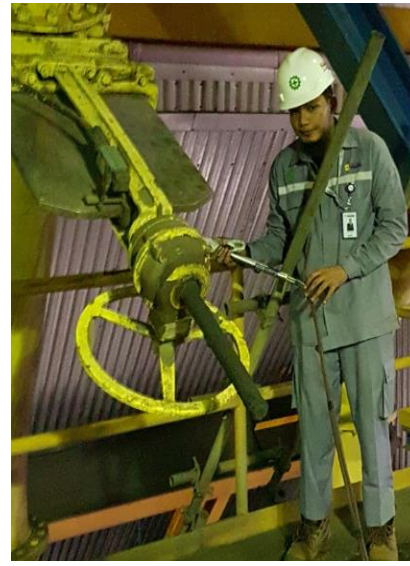
Pemasngan alat uji pada coal pipe
