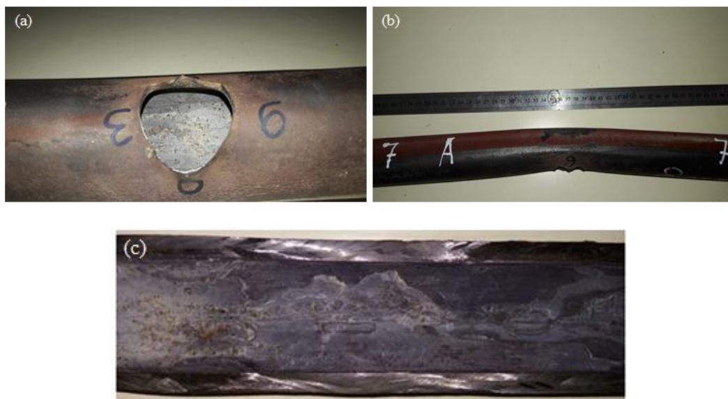
Gambar 4.14 Inspeksi Visual Tube Code 7 ; (a) Tube Mengalami Thin Lip Fish Mouth dan Bulging , (b) Tube Mengalami Deformasi Plastis; (c) Kondisi Permukaan Dinding Dalam Tube yang Rusak
