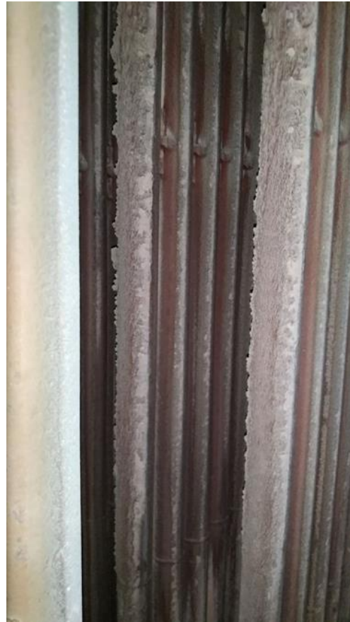
Lampiran 1. Kondisi slagging dan fouling di area secondary superheater outlet
