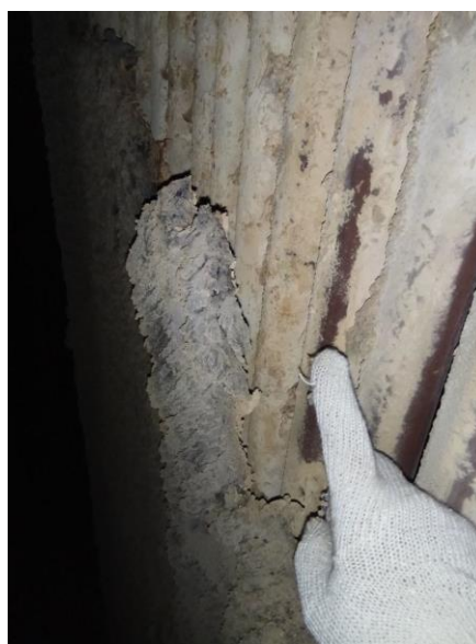
Gambar 4.2 Abu yang Menempel pada Dinding Tube
