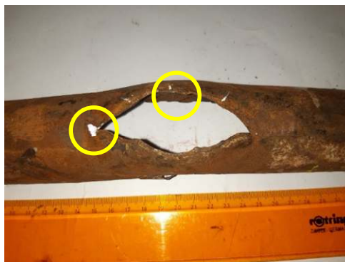
Gambar 3.7 Lokasi pengambilan sampel struktur micro pada tube yang rusak
