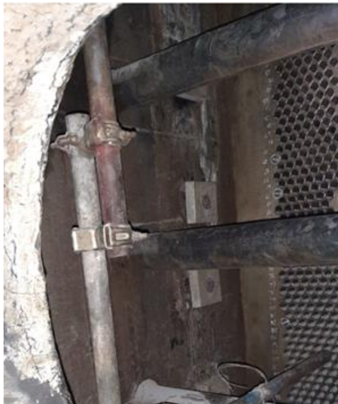
Gambar 3.6 Pemeriksaan cathodic protection pada condenser waterbox
