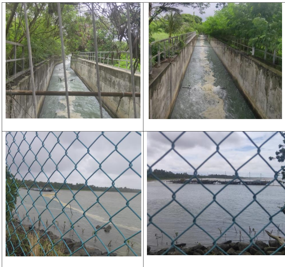
Gambar 3.23 Titik pengambilan sampir air laut (air pendingin) setelah keluar dari condenser Unit 1 PLTU Labuan
