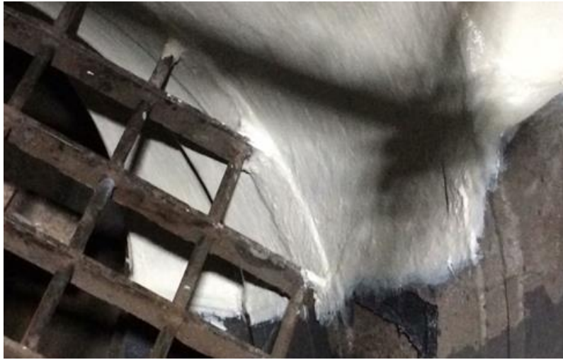
Gambar 3.5 Pemeriksaan elbow perpipaan sisi masuk dan keluar condenser waterbox
