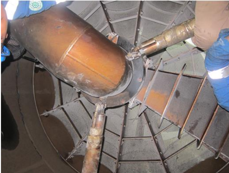
Gambar 3.9 Pemeriksaan debris filter condenser
