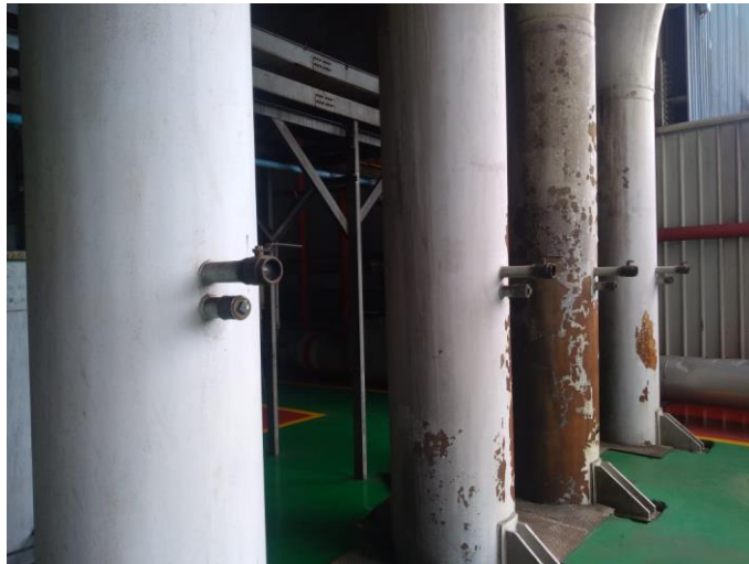
Gambar 3.2 Foto Lokasi Pengambilan Sampel Batubara Dan Coal Fineness Di Coal Pipe Outlet Mill .
