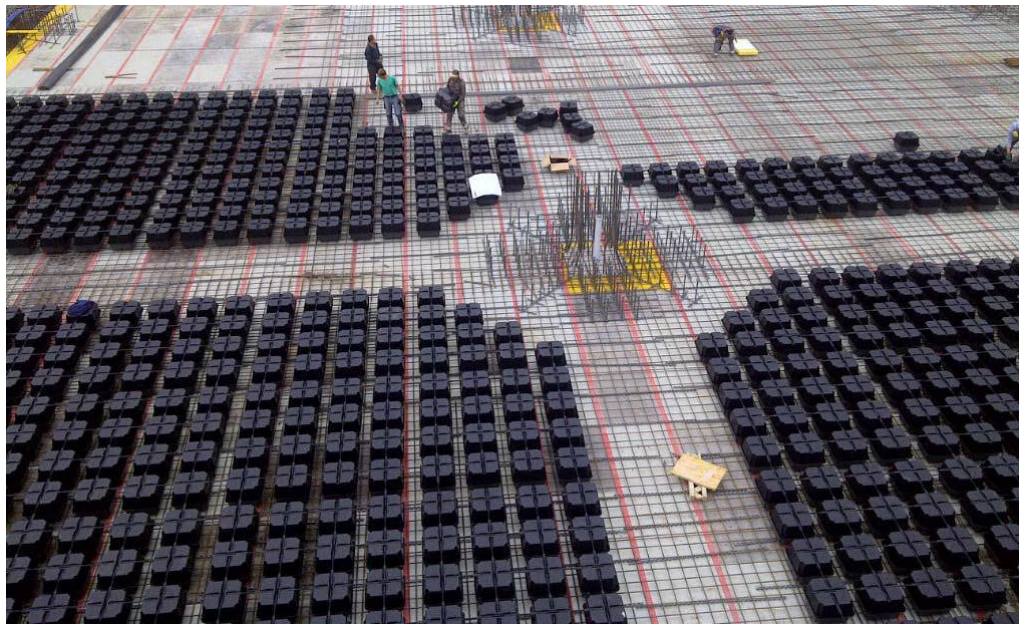
Gambar 2.10 Bangunan industri di Italia dengan bentang maksimal: 16.3 x 17m (sumber : U-Boot beton)
