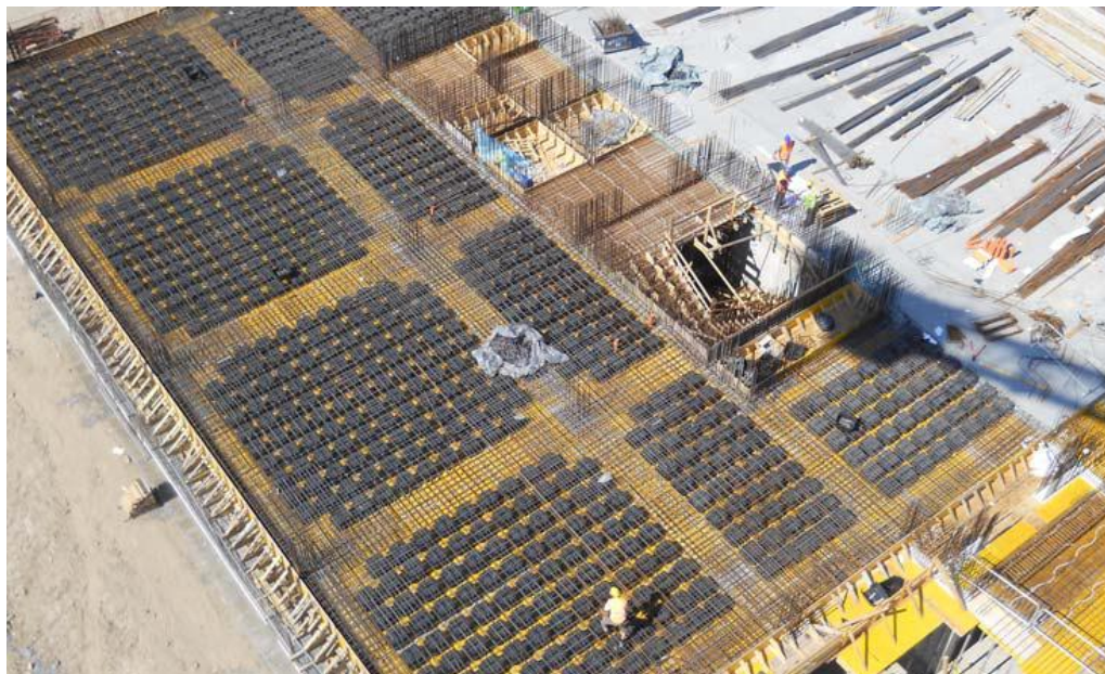
Gambar 2.11 Bangunan rumah sakit di Italia dengan bentang maksimal: 8 x 8m (sumber : U-Boot beton)
