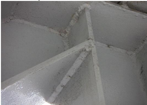
Gambar 2.8 Sambungan Las
