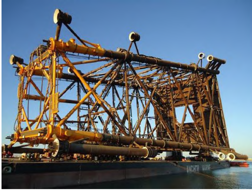
Gambar.2.8 Seafastening jacket pada barge
