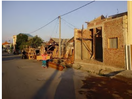
Gambar 4. 17 Kondisi Dinding Bangunan
