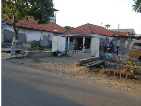
Gambar 4. 15 kondisi atap Bangunan
