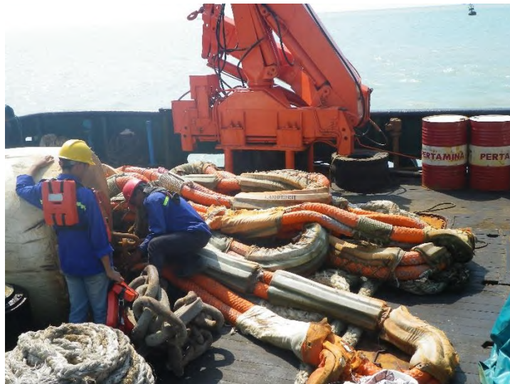
Gambar 1.3. Mooring hawser lama SPM 035 Pertamina yang diganti karena kerusakan (Dokumentasi Pribadi)
