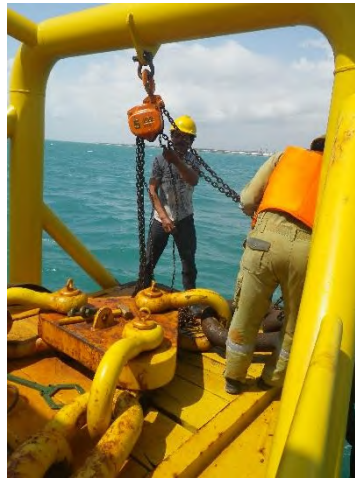
Gambar 4.20. Mooring bridle (Dokumentasi Probad)
