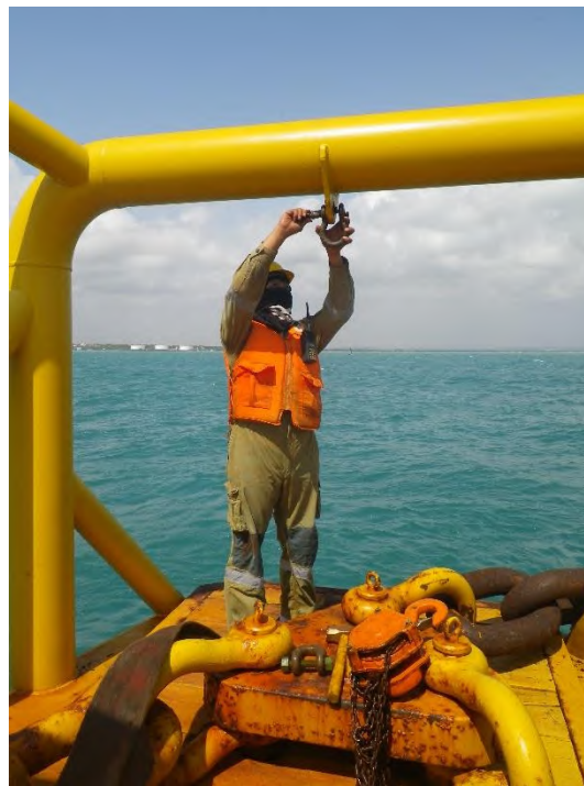
Gambar 4.14. Mooring lugs (Dokumentasi Pribadi)
