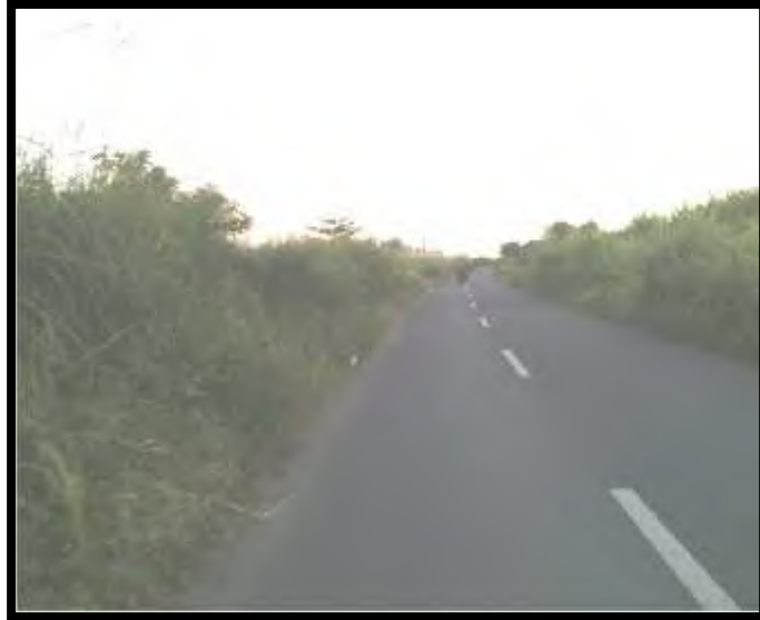
Gambar 4.9 Kondisi Jalan Raya Menuju Dermaga dusun Tlocor
