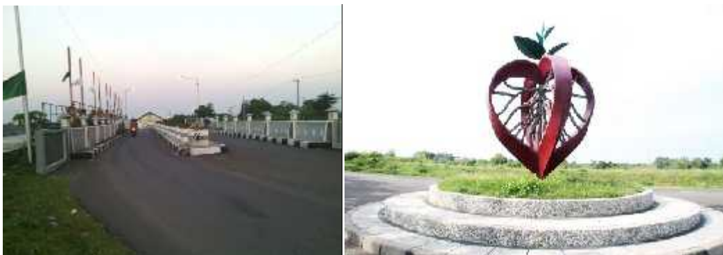
Gambar 4.10 Jembatan Menuju Dermaga dan Tugu Cinta dusun Tlocor
