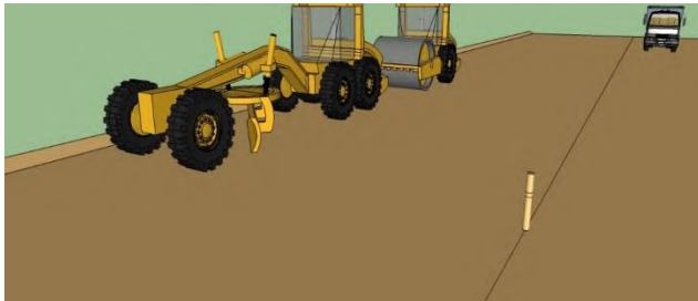
Gambar 5.3 Pembersihan dan pelebaran jalan
