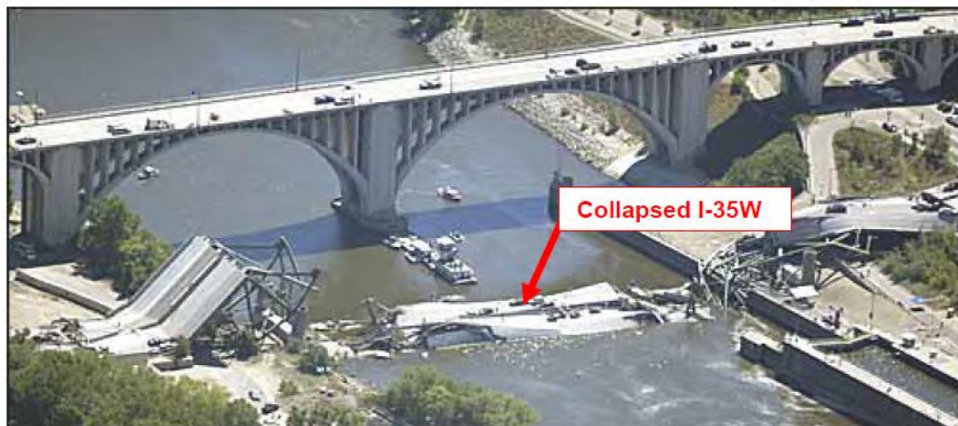
Gambar 1.2 Keruntuhan Jembatan I-35W
