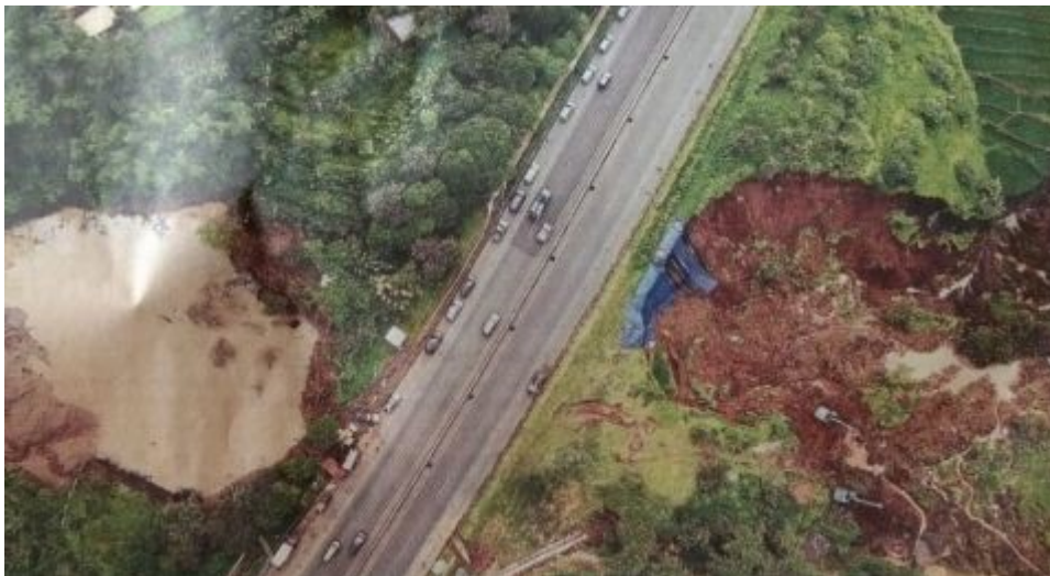
Gambar 1.1. Kelongsoran tebing yang tanahnya tidak mengalami kondisi saturated sebelumnya (Iswinarno, C., 2020)
