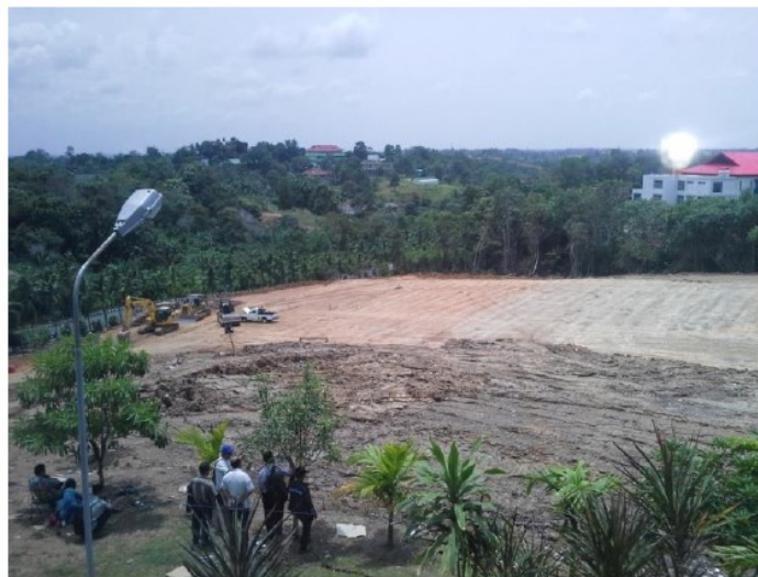
Gambar 5.4. Lokasi pembangunan di mana tanah dasarnya telah dilakukan pengupasan
