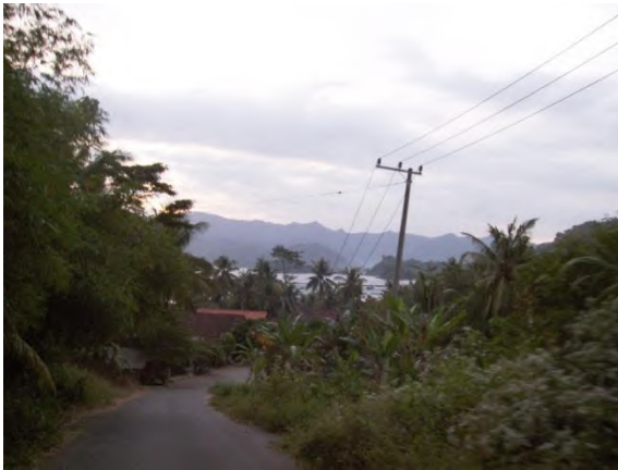
Gambar 5.2. Kondisi eksisting jalan di desa Karangngoso
