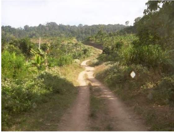
Gambar 5.1. Kondisi eksisting jalan di desa Ketawang
