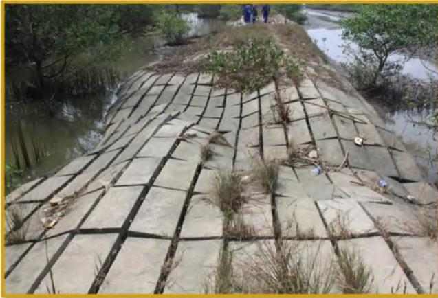
**Gambar 4.11** Konstruksi *Jetty* pada Bagian Terluar Pulau
