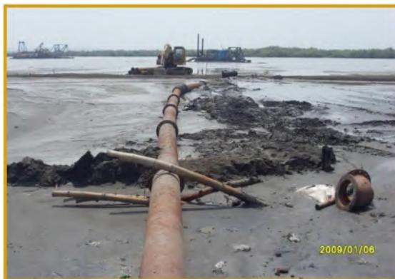
**Gambar 4.6** Aktivitas Pengerukan Muara Kali Porong Dalam Proses Pembentukan Pulau Buatan Spoil Bank
