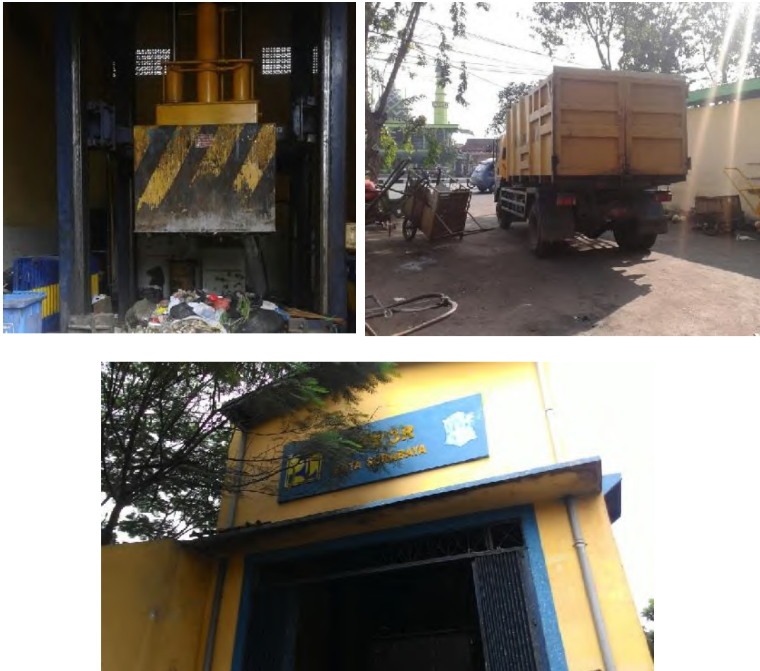
Gambar 2.7. Kondisi Eksisting TPS 3R
