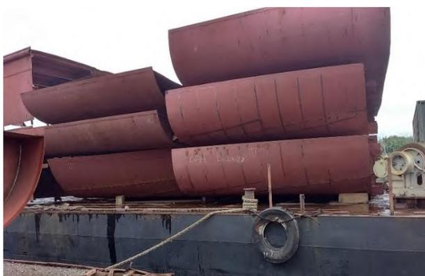
Gambar 4.8. Penumpukan blok di tongkang
