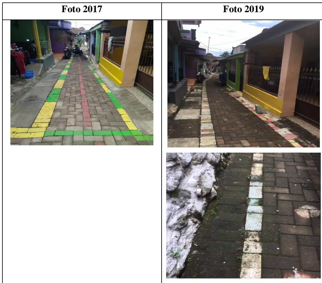
Gambar 4-2 Kondisi Jalan Eksisting di Kelurahan Bandulan
