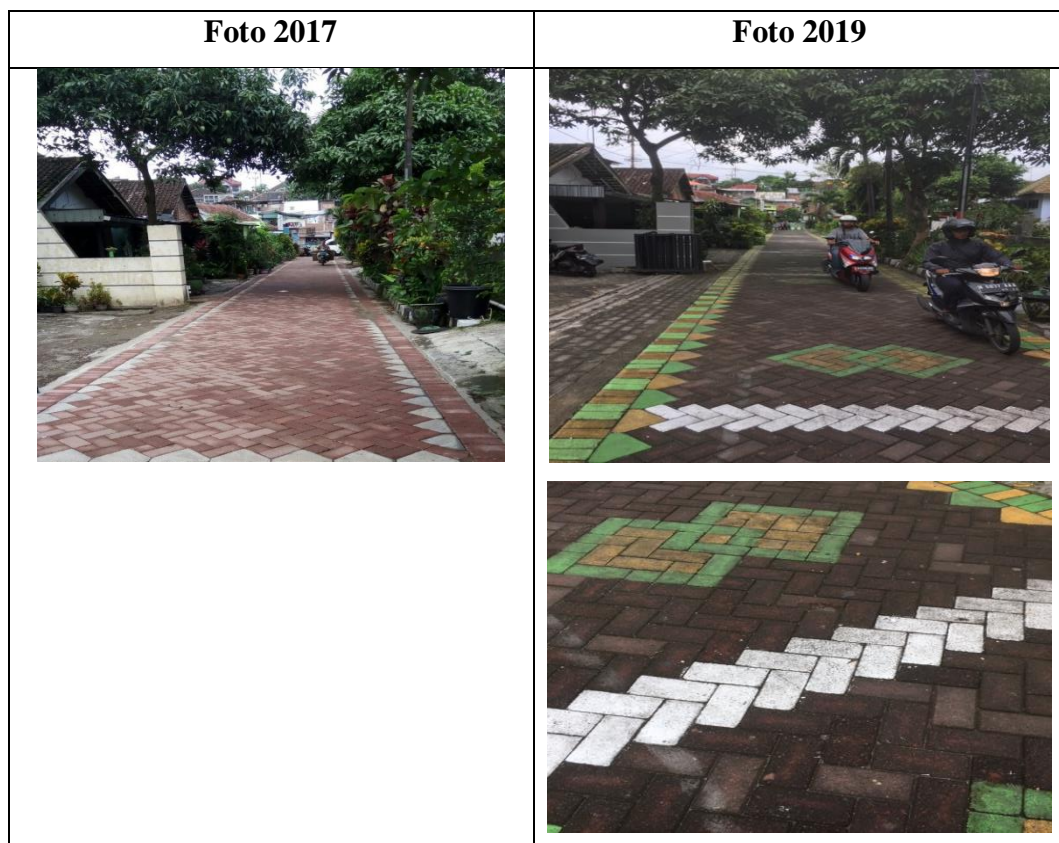
Gambar 4-10 Kondisi Jalan Eksisting di Kelurahan Samaan
