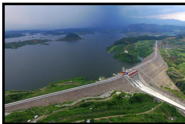
Gambar 2.5 Bendungan Jatigede (BBWS Cimanuk-Cisanggarung)
