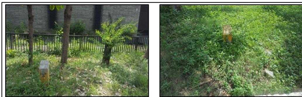
Gambar 4.2 Pemanfaatan Bagian-Bagian Jalan Berupa Jaringan Utilitas
