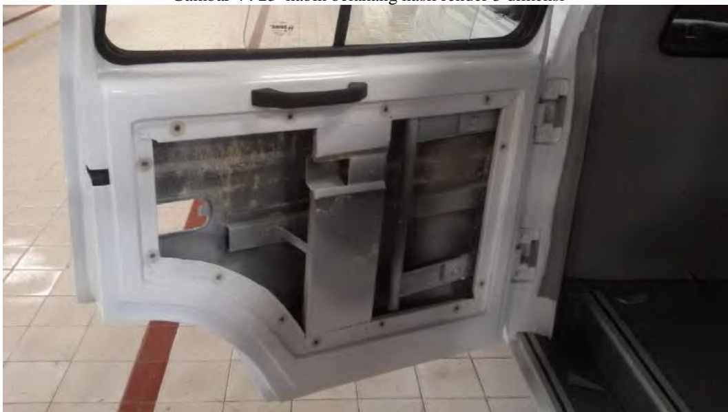
Gambar 4 . 24 pemasangan engsel pada pintu( sumber; dokumentasi pribadi)
