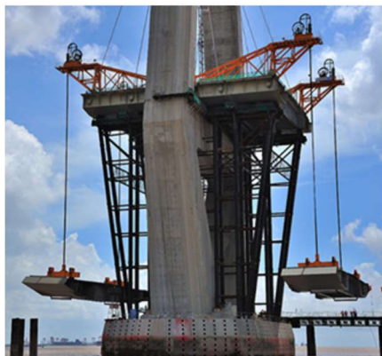
Gambar 4. 92 Ilustrasi Form Traveller yang Digunakan
