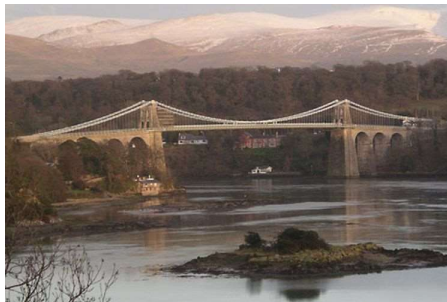
Gambar 2. 1 Jembatan gantung ( suspension ), Selat Menai, UK
