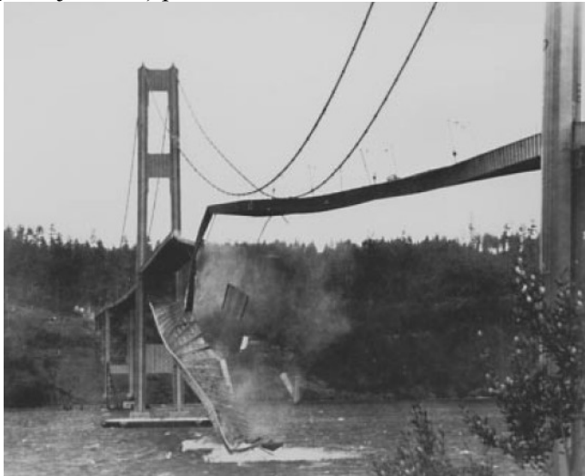
Gambar 2. 31 Greak torsi Jembatan Tacoma sesaat sebelum runtuh, 7 Nopember 1940
